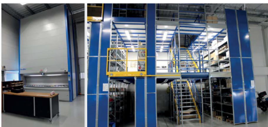
► Sklad je vybaven výškovým základacím systémem Kardex a na míru vyrobeným regálovým systémem
